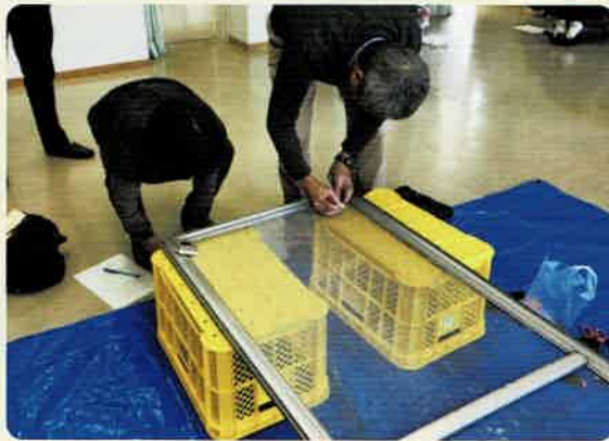
網戸の張り替え作業中
