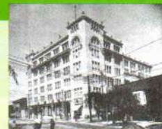
松坂屋(名古屋大津町) 第一期工事完成(大正14年)
